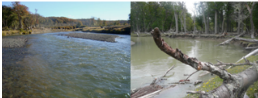
Figura 4. Sector 2. Vista general del cauce: porción baja (der.) y alta (izq.).
